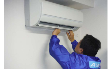
エアコンクリーニング
