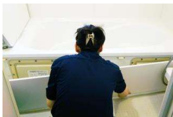
お風呂エプロン内清掃(前面パネル)
