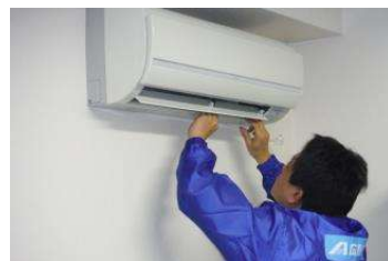
エアコンクリーニング
